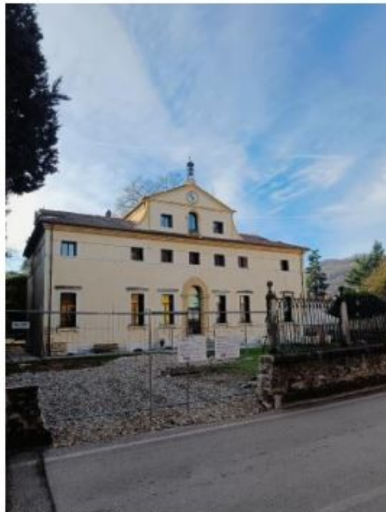
Biblioteca Previsti lavori strutturali e nuove tecnologie VEMO.
